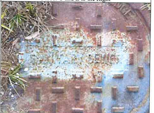
Sewer Manhole on Parcel E
